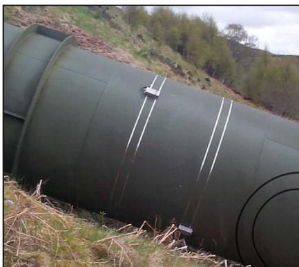
Монтаж накладных датчиков осуществляется с помощью крепежа, входящего в комплект поставки расходомера.
